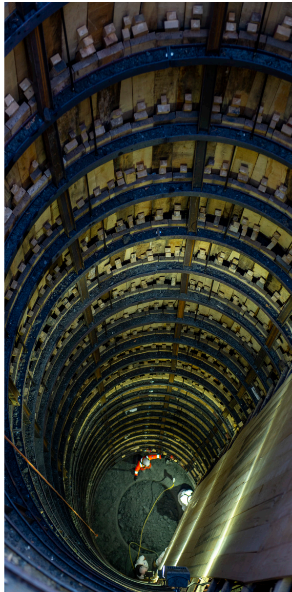
Access Manhole Shaft
